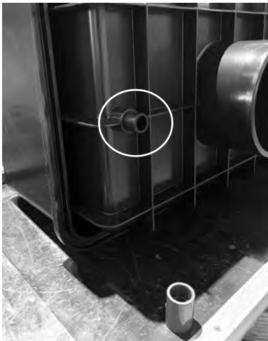
Image 2 BaduJet Turbo Pro - gluing conduit adapter
