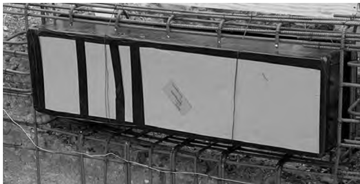
Image 4 BaduJet Turbo Pro - Jet placement in rebar
